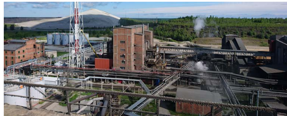
Joonis 10: TSK-500 põlevkiviõli tootmise tehas
