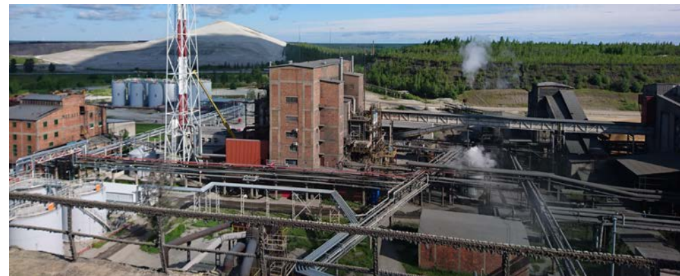
Joonis 10: TSK-500 põlevkiviõli tootmise tehas
