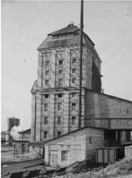
Foto nr 4 Korsten on kinnitatud hoone nurka
