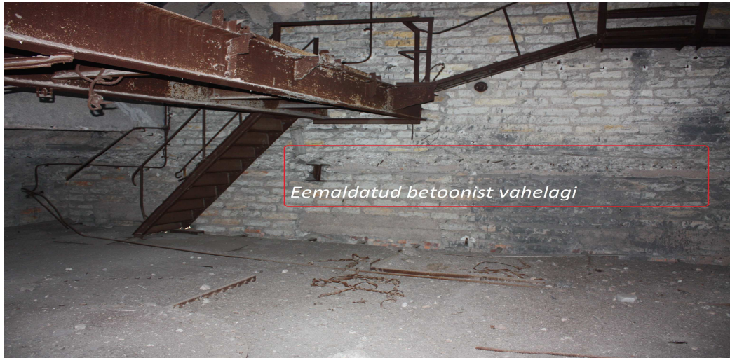
Foto nr 7 Eemaldatud betoonist vahelae konstruktsioon
