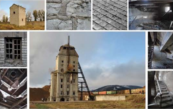
Funktsioon: tükipõlevikvi punker (1924–1943), korruseidilava katseretortid paiknemiskort (1946–1985). Restaurerimisel-rekonstrueerimisel jätta loetavaks torni erinevad kasutusetapid.
