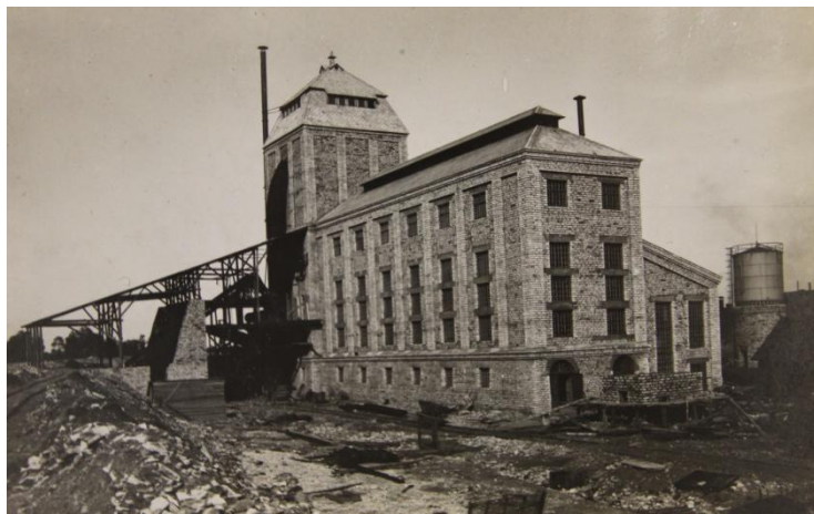
Kohtla-Järve I õlivabriku torni ajalooline ülevaade
