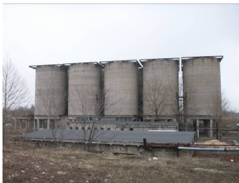
Pilt 3. 10 raudbetoonist silindrikujulist hoidlat
