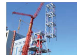
VKG uue tehase ehitustööd suvel 2009.
