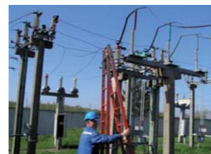
Elektriühenduslikud tööd VKG Elektrivõrgud OÜ-s.
